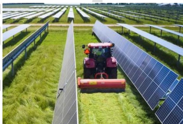
Solcellepaneler med tracker system.
