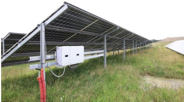
Foto: Eksempel på inverter, som placeres under solcellerne. Inverterne omdanner jævnstrømmen til vekselstrøm.
